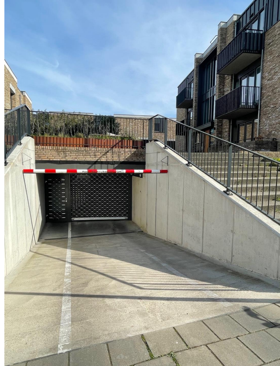
Toegang tot de ondergrondse parkeergarage.
